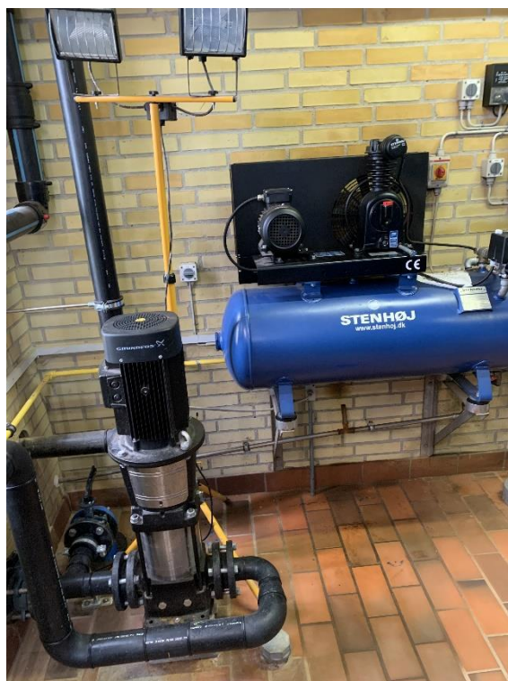
Skyllepumpe og kompressor
