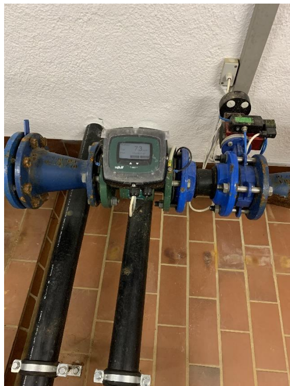
Vandmåler, afgang vandværk
