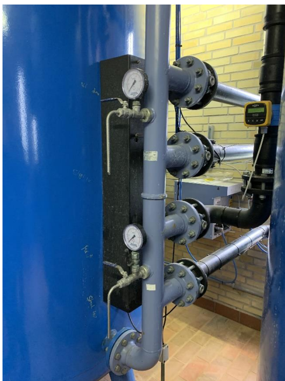
Prøvetagningshane før og efter filter
